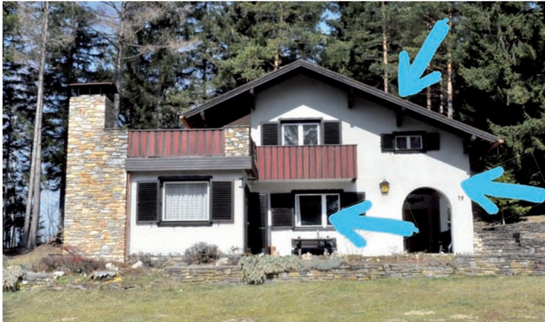
Planer und Foto: aap.architekten ZT GmbH
